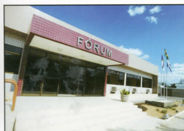
Fórum de Betânia (Construção)
