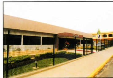
Fórum Lagoa do Itaenga (Construção)
