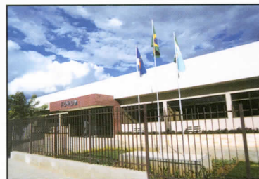
Fórum de São José do Egito (Construção)
