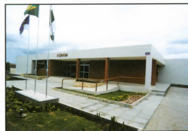
Fórum de Bodocó (Reforma)
