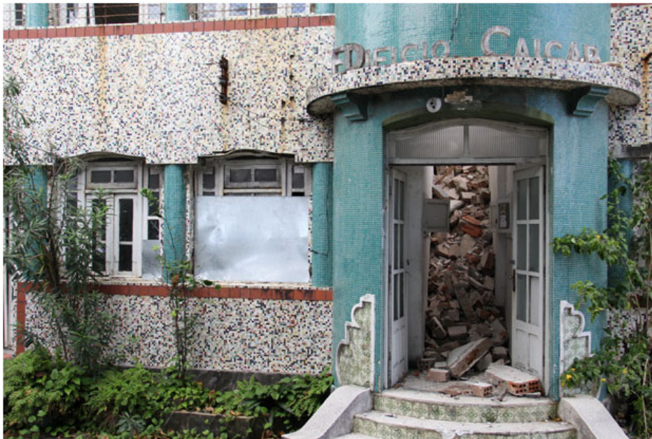
Construtora Rio Ave Empreendimentos Ltda., que não respeitou o processo de tombamento e deu início à demolição do Edifício Caiçara pode ser multada em R$ 1 milhão. Foto: Bruna Monteiro DP/D.A Press/Arquivo
