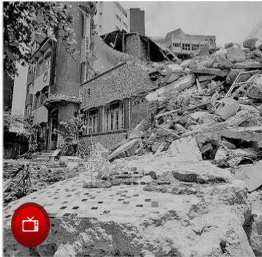
DEMOLIÇÃO Imóvel foi parcialmente destruído na sexta-feira
