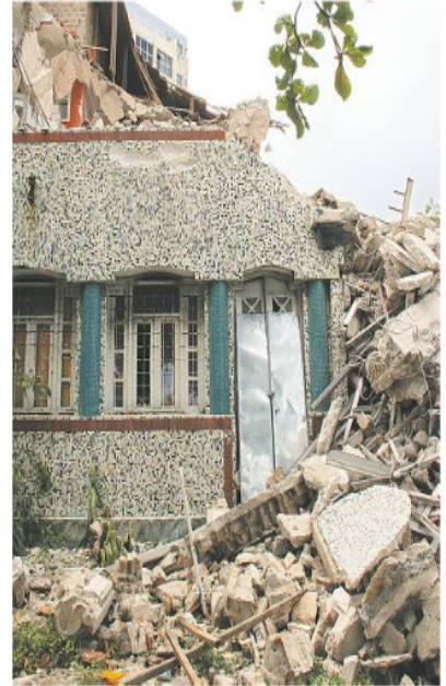
Parte do Caiçara já foi demolida na última sexta-feira
