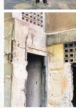
PERÍCIA Ferrugem, estrutura das colunas exposta e rachaduras foram encontradas no Bloco B1
