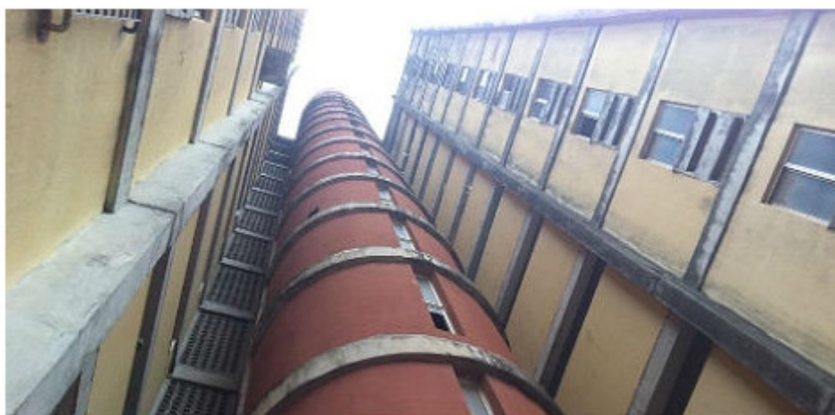
Conjunto é formado por 37 blocos, construídos há cerca de 28 anos Foto: Marília Banholzer/Portal NE10
