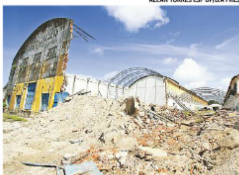
Obra de demolição foi interrompida após ocupação
