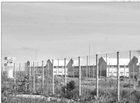
CIR de Itaquitinga depende de 15% das obras para poder entrar em operação
