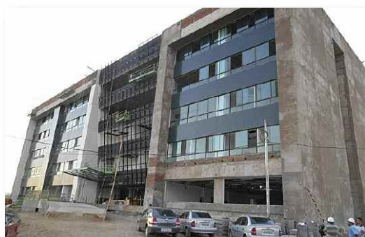
Serra Talhada – 8.668,36 m 2 , com 17 varas, uma Central de Conciliação, uma Central de Cartas Precatórias, uma Sala de Depoimento Acolhedor e um Juizado Cível. Inaugurado em janeiro de 2016
