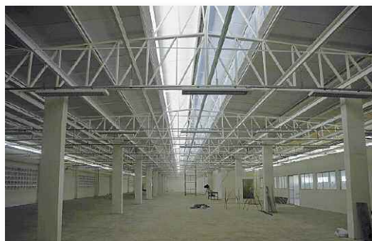
Galpões do almoxarifado e patrimônio em Jaboatão dos Guararapes
