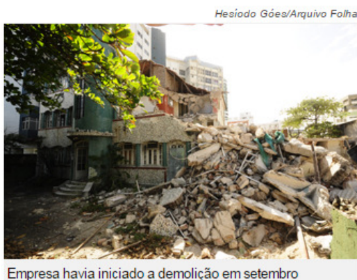
Empresa havia iniciado a demolição em setembro
