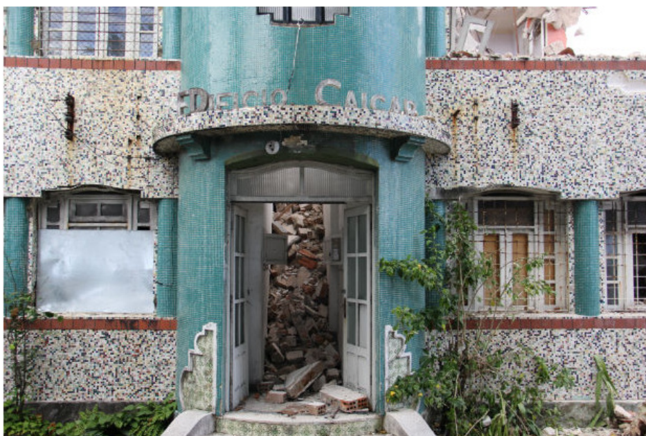
Em 2013 prédio foi parcialmente demolido. Foto: Bruna Monteiro/DP/D.A Press (Arquivo)
