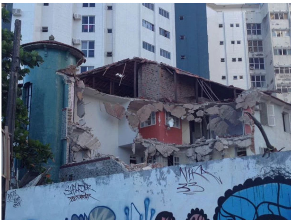
Edifício Caiçara, na Avenida Boa Viagem, está parcialmente demolido (Foto: Alan Garcia / TV Globo)
